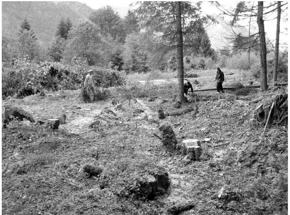
Am Beginn der Freilegungsarbeiten werden Strauch, Buschwerk und Bäume entfernt Foto: ZME
