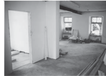
Bau- und Renovierungsbeginn in der alten Volksschule Jänner 1991
